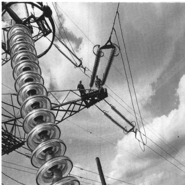
Слика 3.4.б Изглед на изолаторски синџир
