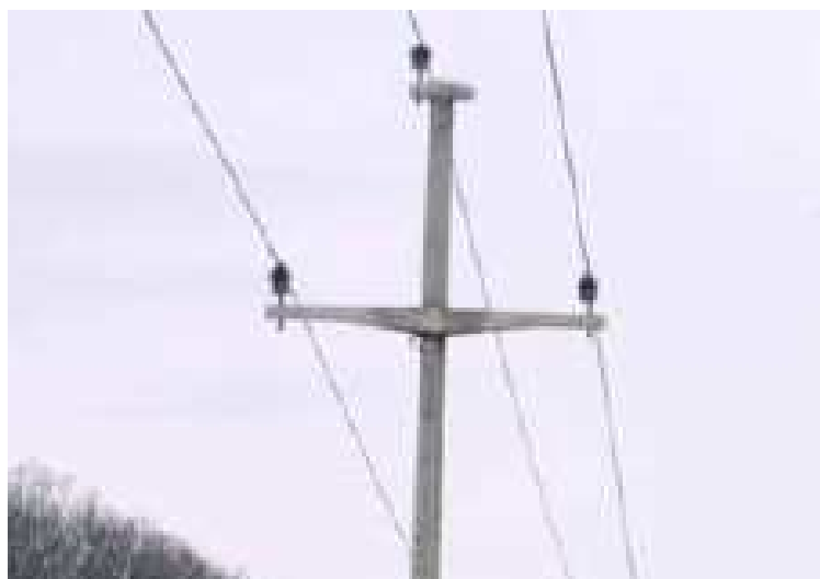
Слика 3.2.б Потпорни изолатори на 10 kV бетонски столб
