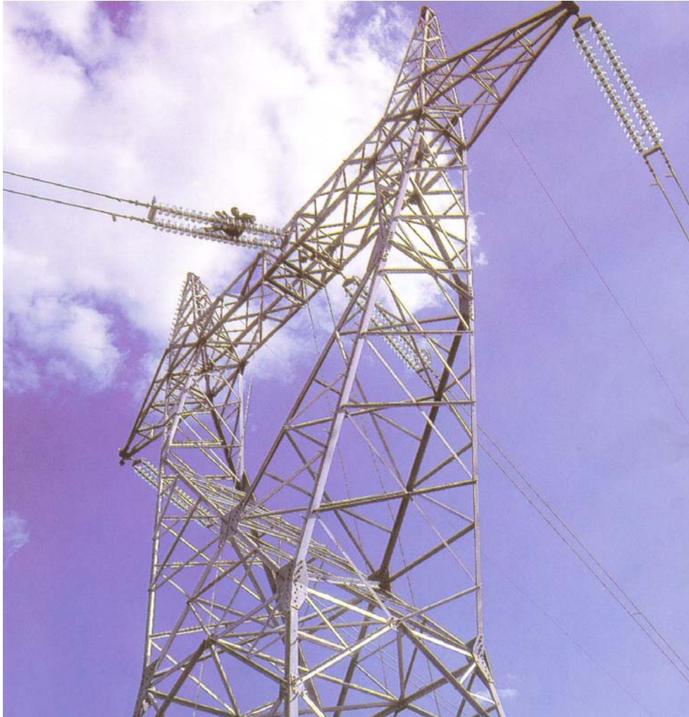
Слика. Монтажа на еден 400 kV аголно-затезен столб (чел. решеткаст)
