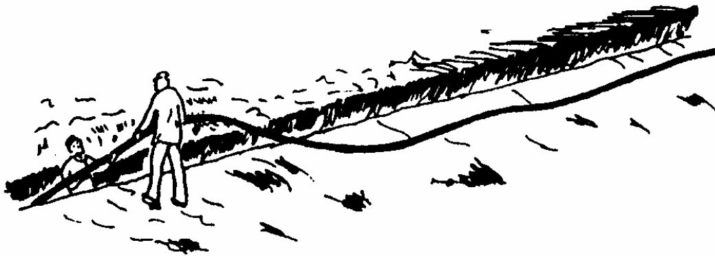
Слика. Рачно полагање на енергетски кабел во кабелски ров
